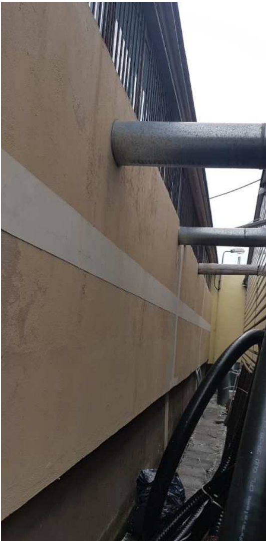
Fot 5: Elewacja południowa w osiach 5÷8
