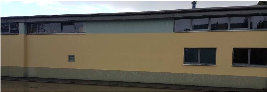
Fot 4: Elewacja południowa w osiach 2÷5
