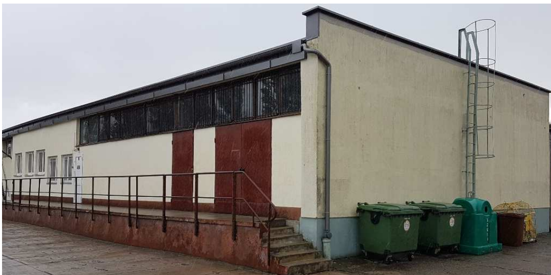
Fot 3: Elewacja północno-zachodnia
