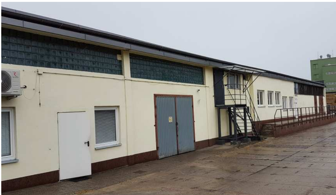
Fot 2: Elewacja północna
