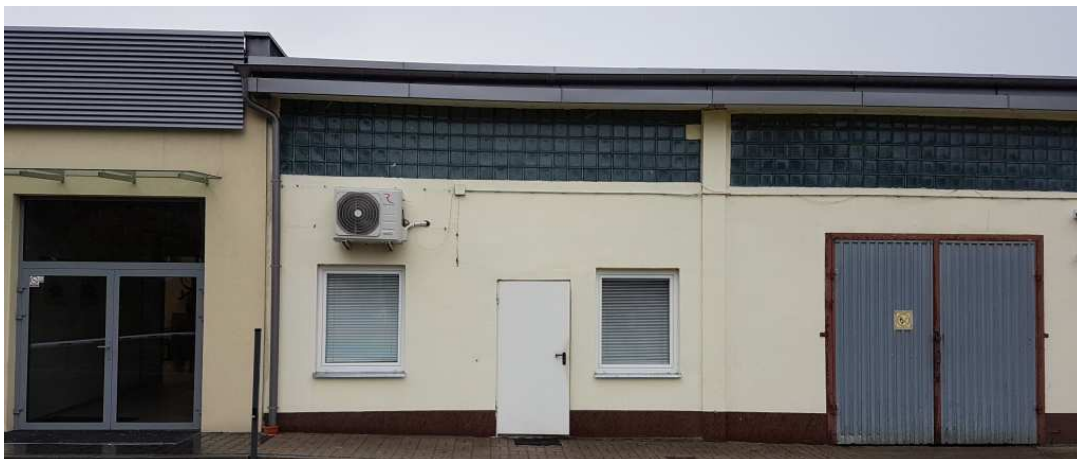
Fot 1: Elewacja północna w obrębie portierni
